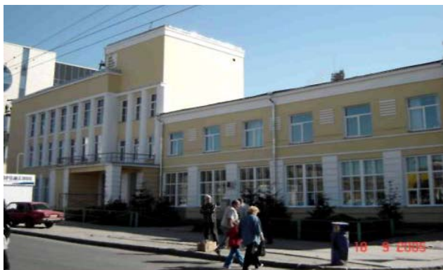
Рис. 2. Здание аэроклуба по ул. Крылова, 24, в котором располагался НИИГАиК в 1954 г.
