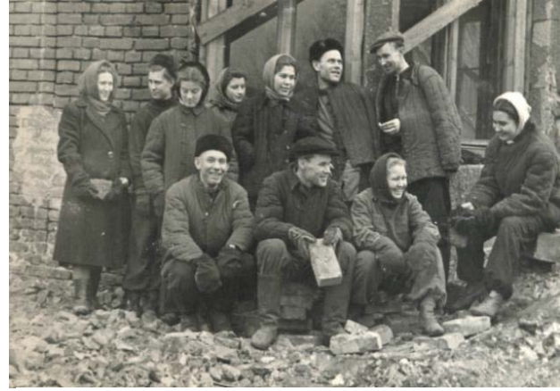
Рис. 5. Восстановление здания после пожара
